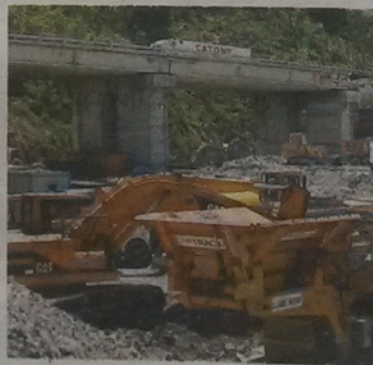
Lavori sulla Salerno-Reggio C.
